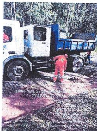
Figura 33: Operação de remoção dos resíduos sólidos da atividade para destinação final.
