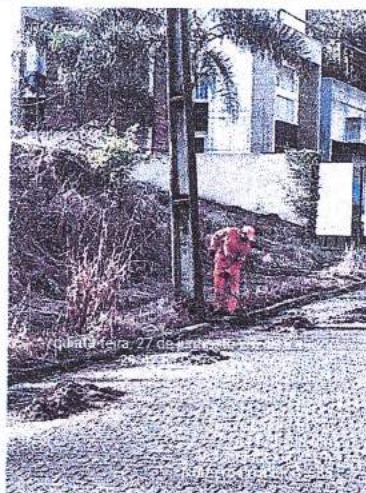
Figura 35: Atividade de capina em andamento.
