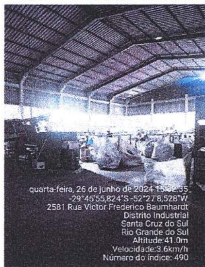
Figura 16: Área de triagem da unidade.
