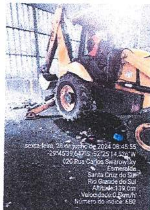
Figura 23: Processo de compactação dos rejeitos para otimização da destinação final.
