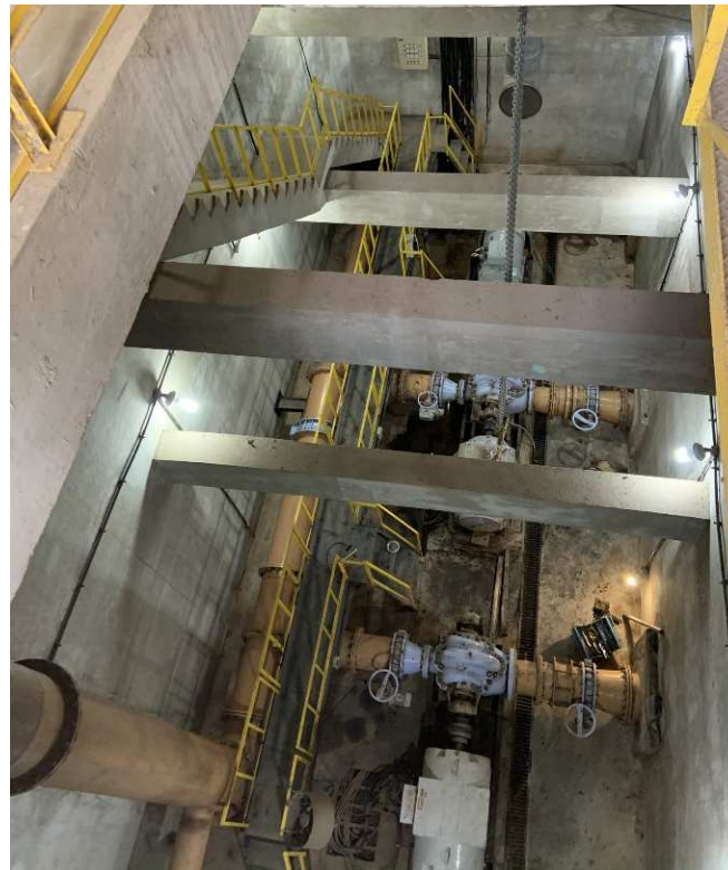
FIGURA 2.19 – Conjuntos motobomba do 1º recalque
