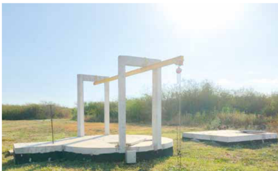
Emissário de Esgoto Tratado (São Borja)
