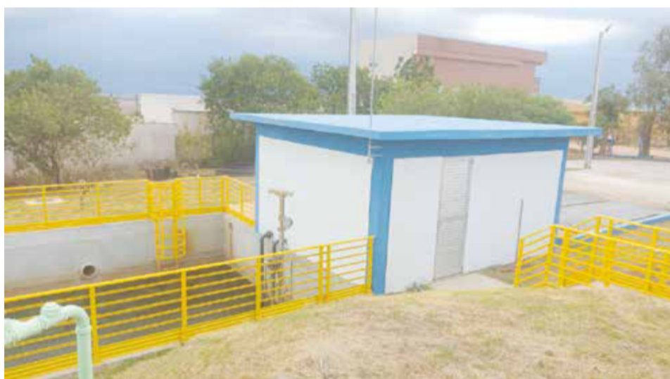
Tanque de Lodo da ETA Aceguá
