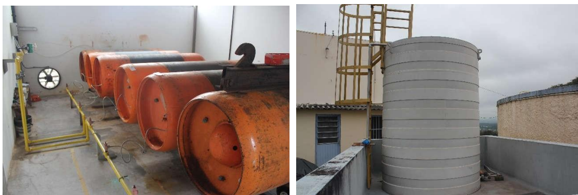
Figura 16: Área de depósito de cloro gás e ácido fluossilícico.
