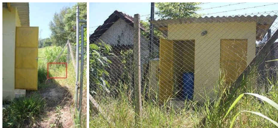
Figura 51: Unidade de tratamento Júlio de Castilhos.
