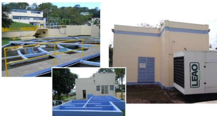
Figura 39: Melhorias na ETA.
