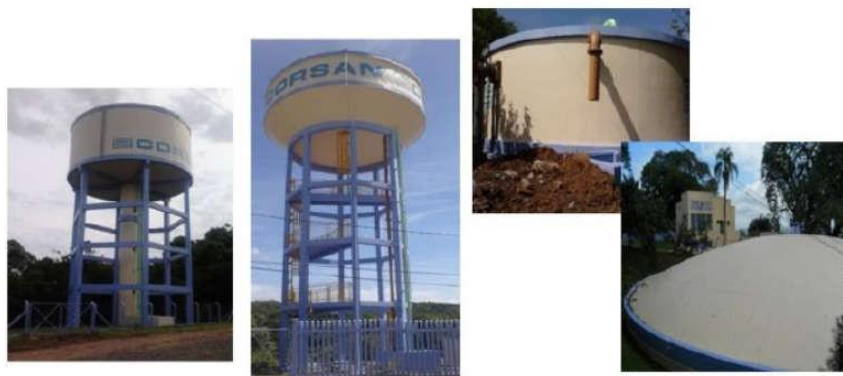
Figura 37: Recuperação dos reservatórios.
