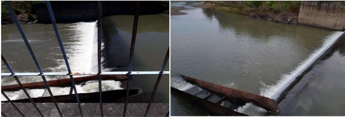
Figura 6: Vista geral da barragem de nível e captação de água no Rio Pardinho.
