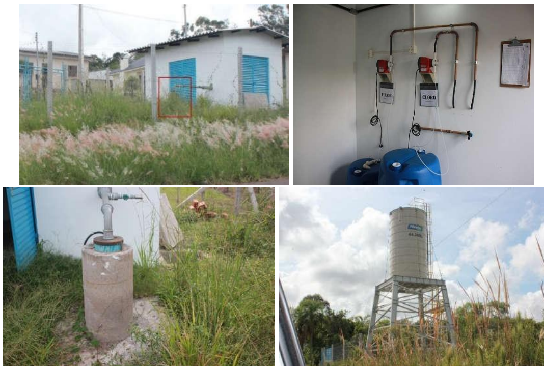
Figura 54: Unidade de Tratamento em Cerro Alegre Baixo II. Destaque para inadequação quanto a acesso e poço. Reservatório próximo a Unidade de Tratamento 4ª Linha Nova.
