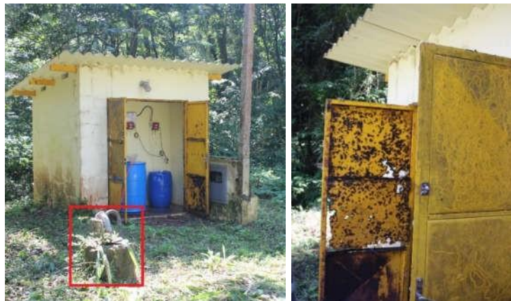
Figura 62: Unidade de Tratamento em Felipe Nery.
