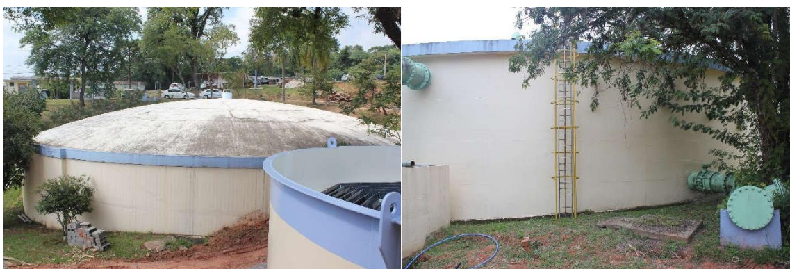
Figura 22: Reservatório R2 (3000 m 3 ) e R3 (2250 m 3 ) na ETA.
