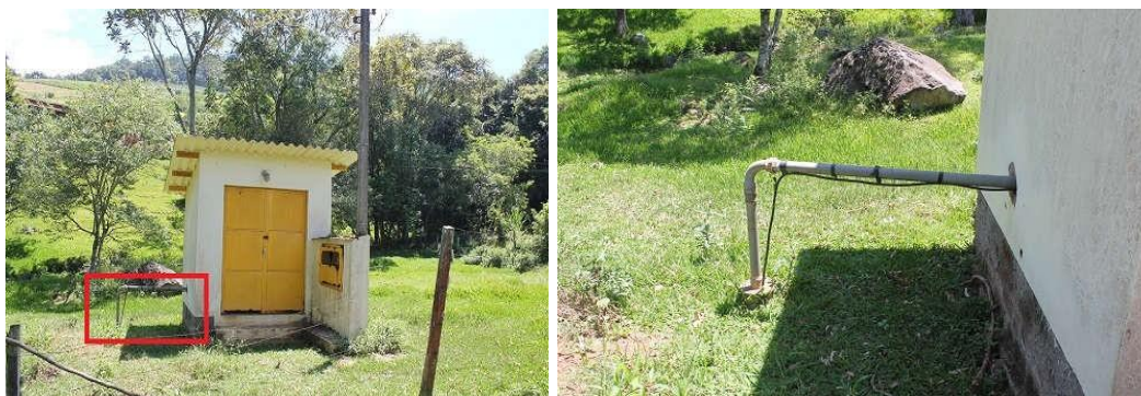
Figura 44: Unidade de Tratamento em Linha Antão, com destaque para área em torno.
