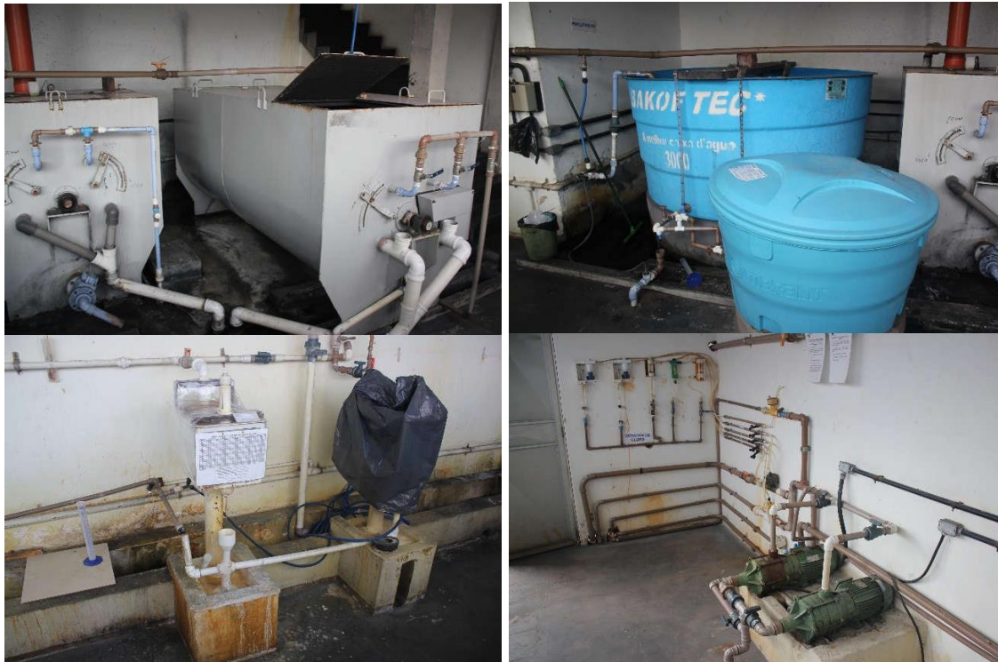
Figura 17: Dosadores de caneca para carvão ativado (a), dosador de polímero (b), dosador de Sulfato de Alumínio (c) e dosadores de cloro gás (d).
