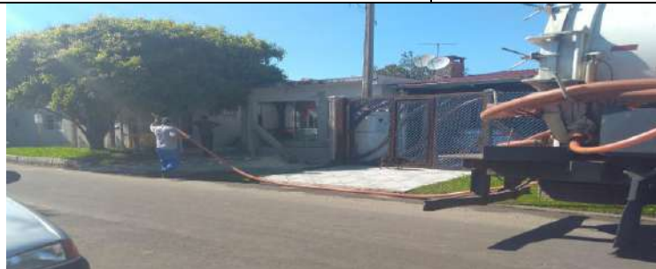
Chegada ao imóvel-Manobra de instalação
