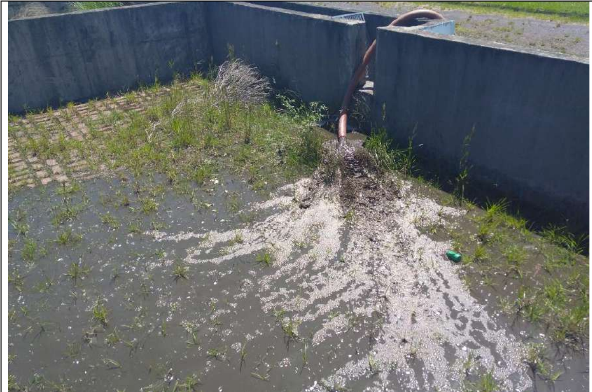
Descarte de lodo de fossa em leitos de secagem (03/01/2018)
