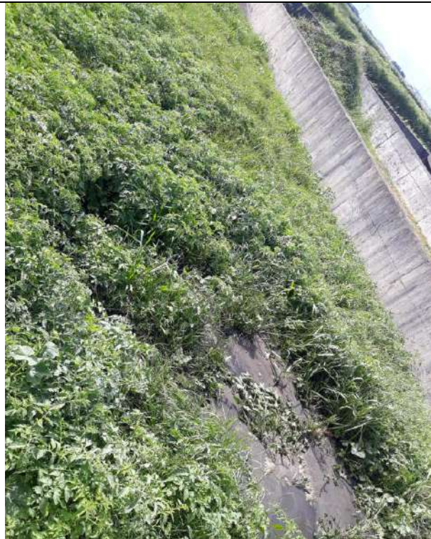
Descarte de lodo de fossa em leitos de secagem (23/02/2018)
